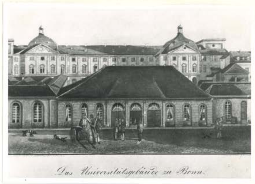
Abb. 11: Das alte Universitätsgebäude zu Bonn. Die chirurgisch-ogenärztliche Klinik befand sich um 1835 im Universitäts- Hauptgebäude. (siehe Grundriß)
